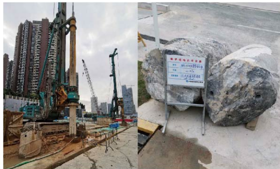
• 深圳南山某工地
