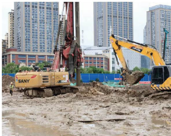
• 武汉江夏某工地
