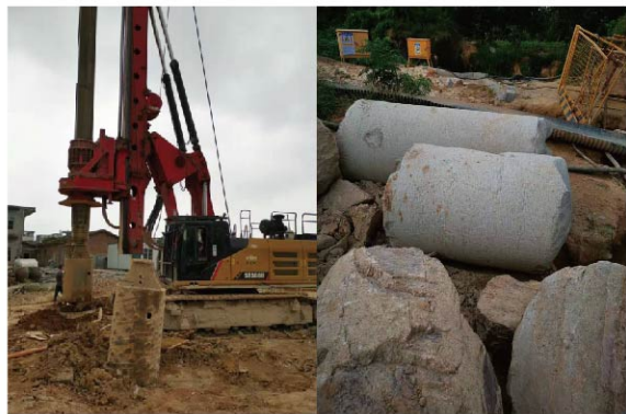
• 福建莆田某工地
